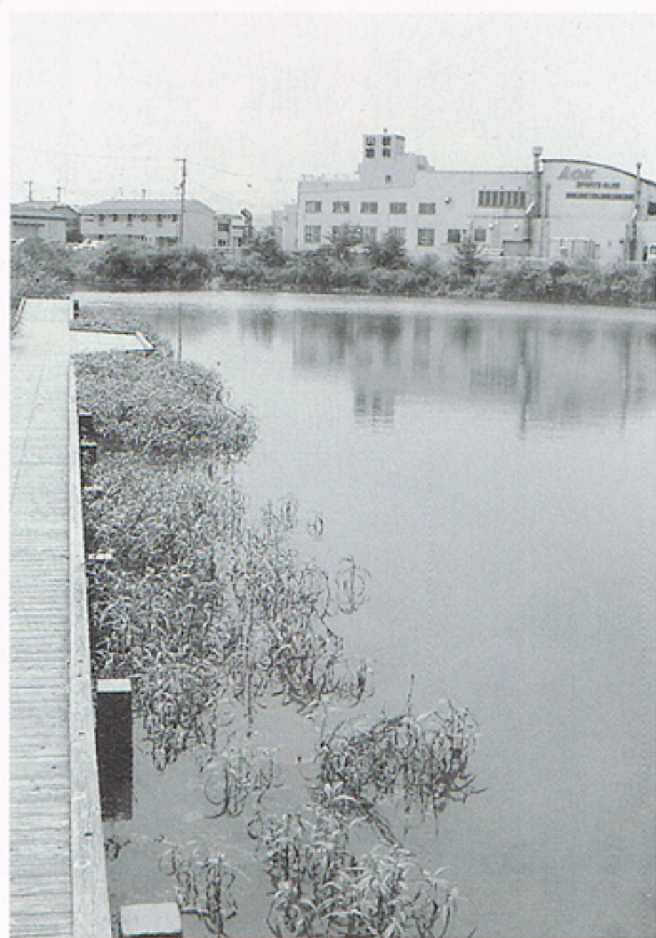
正法寺川 (新富吉橋下流)
